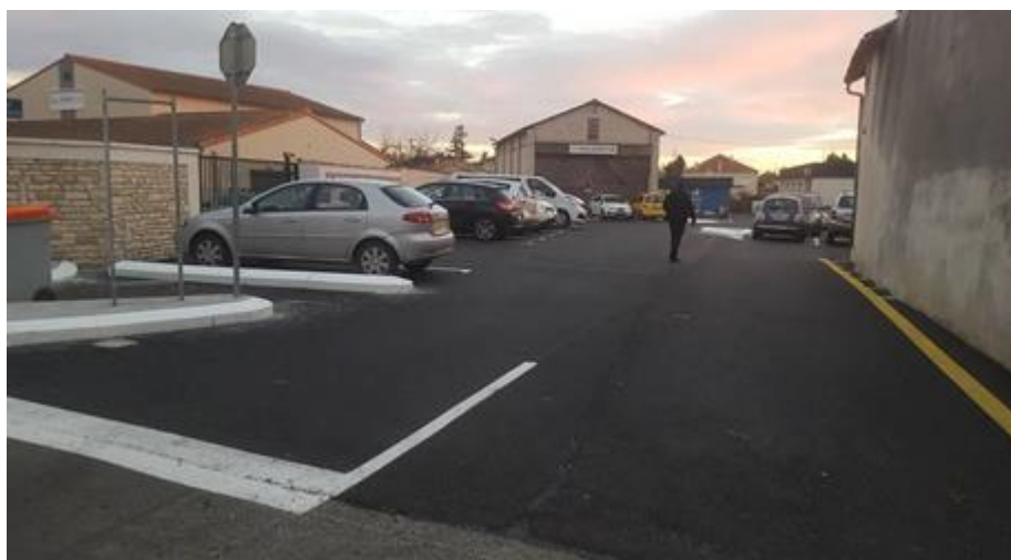
Après les travaux
