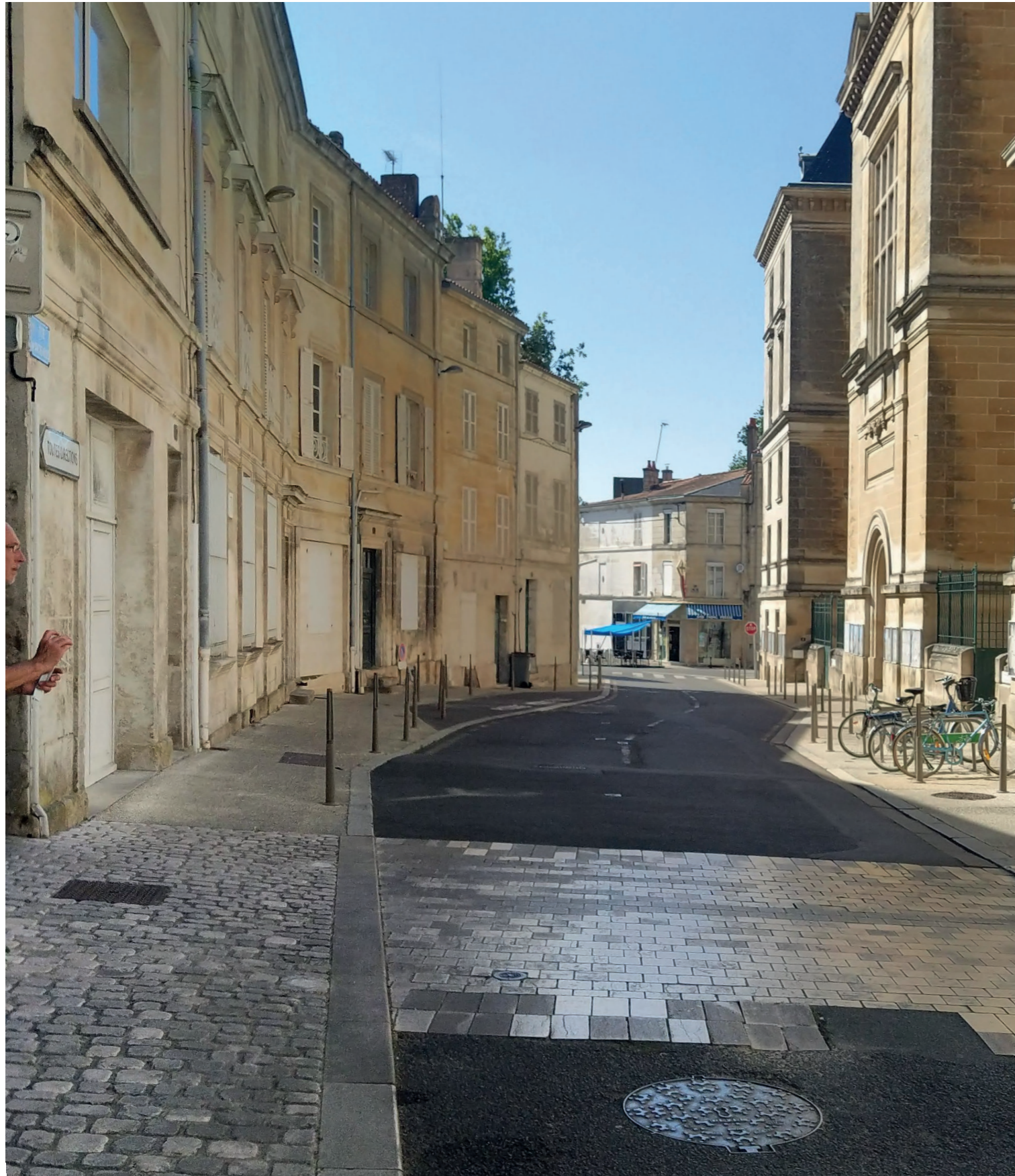
La rue de l'Ancien Musée / enrobé, pavage
