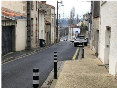
1 er Phase du 17/01/2019 au 01/03/2019 N°(81-93) Secteur Basse rue du Vivier
